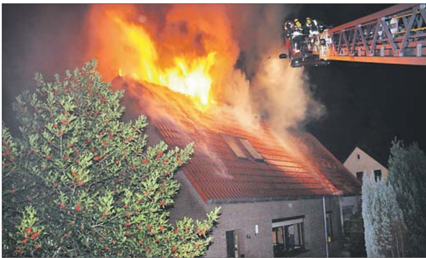
Die Doppelhaushälfte kann nach dem Brand nicht mehr bewohnt werden. Menschen kamen nicht zu Schaden. Foto: Koschmieder
