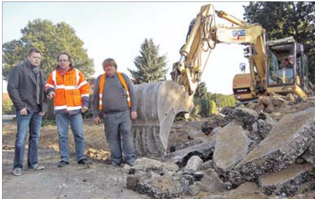
Herausgerissene Asphaltstücke und Bagger bestimmen das Bild am Ortseingang Drakenburgs. Mit der Erneuerung der Ortsdurchfahrt beschäftigt sind neben anderen Lars Marquard, Geschäftsführer der ausführenden Firma Gross-Straßenbau, Kreisstraßenmanager Volker Sangmeister und Bauarbeiter Klaus Weiglein (von links). Foto: Muschol
