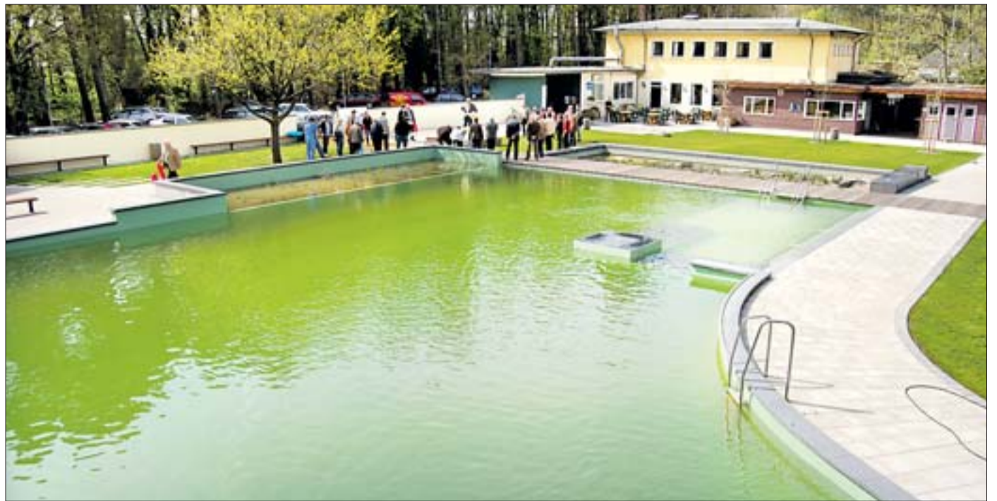
Blick vom Drei-Meter-Sprungturm auf das Schwimmbecken des umgebauten Steimbker Freibades.
