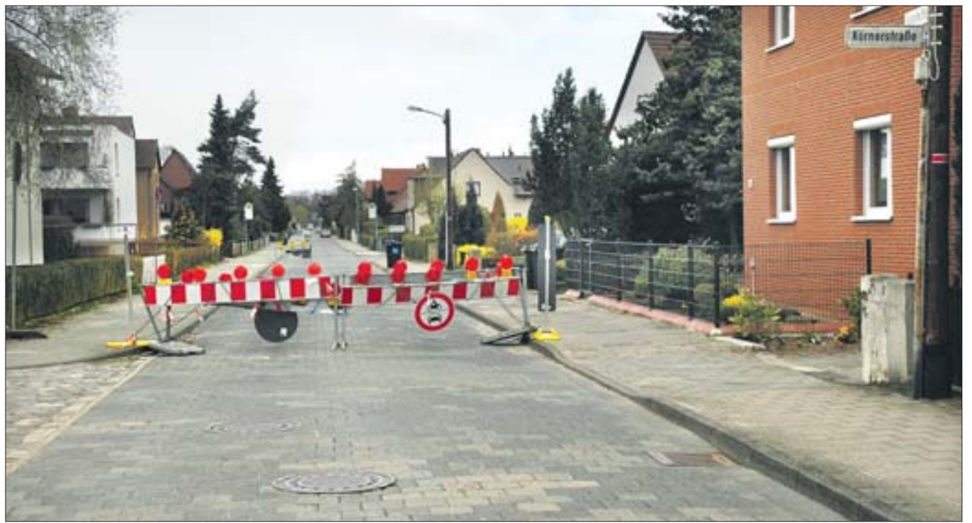
Auf der Holtorfer Straße werden Pfähle aufgestellt, um sie auf zwei Meter Durchfahrtsbreite zu verengen. Die Sperrung für Lkw erfolgt zwischen Körnerstraße und Großer Heide – dort, wo jetzt die Vollsperrung eingerichtet ist. Foto: Lachnit
